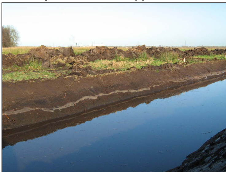
Figuur 15: De laag klapklei in het veen bij de Onlandse dijk
